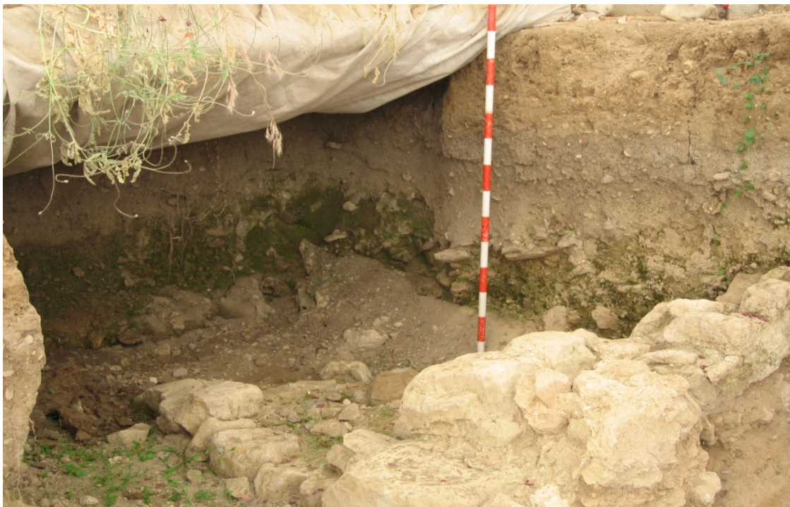
2.- Humedades en la esquina noroeste de la excavación de la villa, procedentes del coluvión.
